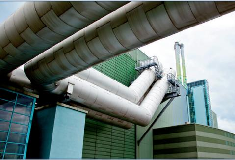
Das entstaubte Rauchgas gelangt über einen Sammelkanal in die zweite Reinigungsstufe. In dem sogenannten sauren Wäscher, werden Chlorwasserstoff (HCl), Fluorwasserstoff (HF) und Schwermetalle ausgewaschen. Das Waschwasser wird mit Natronlauge (NaOH) neutralisiert. Reaktionsprodukt ist in erster Linie Nutzsatz (NaCl).
